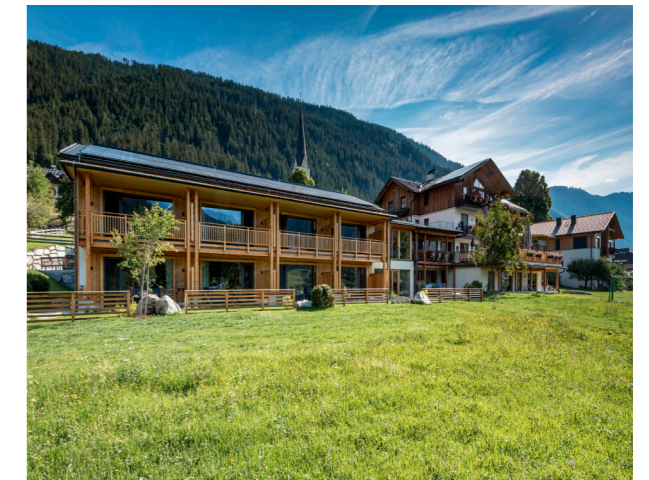
Erweiterungskörper in Holzbauweise
